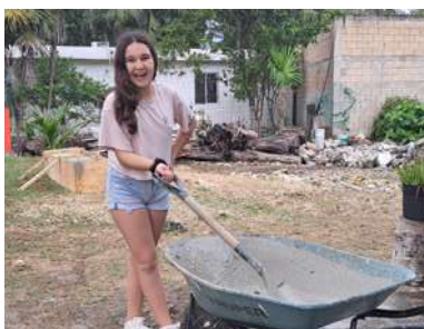
Colado de 2da y 3era Ecobanca donada por Fundación Oasis
