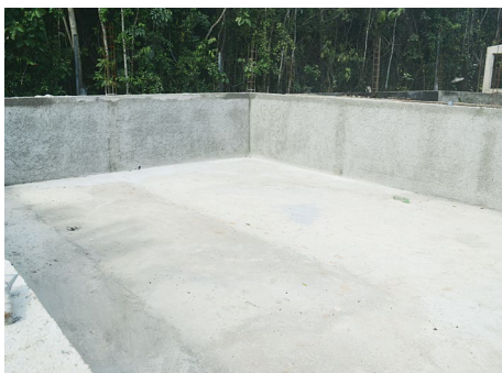
En la Unidad de Aprovechamiento de Residuos Orgánicos se reciben todos los residuos sólidos que se generan en los hoteles Oasis
