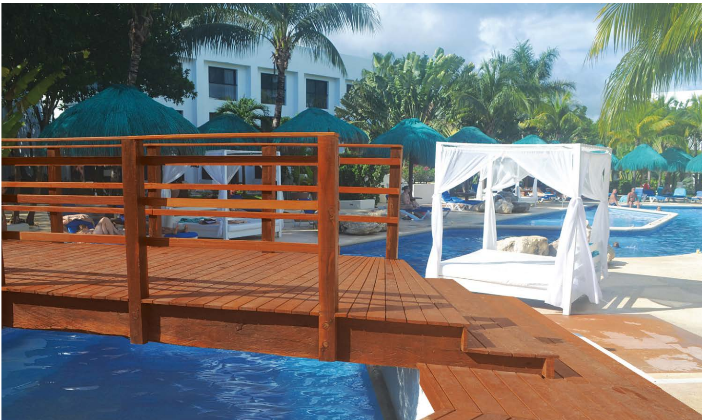
Acceso renovado para área de albercas
